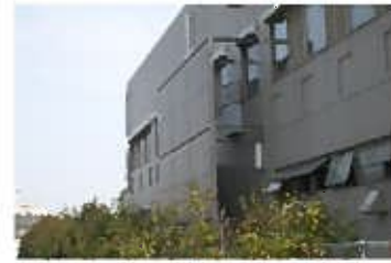
室外機の目隠し。建築物全体のデザインとの調和にも配慮されている。
