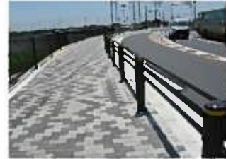
柵状の安全施設
