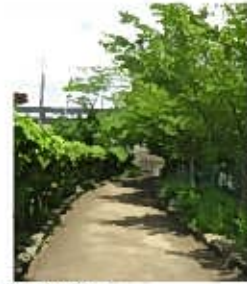
土系舗装を施し 自然な風合いを醸し出す路面
