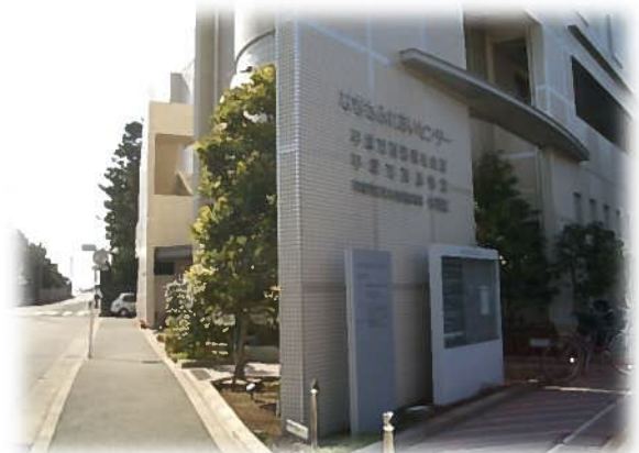
外壁との調和に配慮し、建築物全体としてまとまりのある表示サイン
