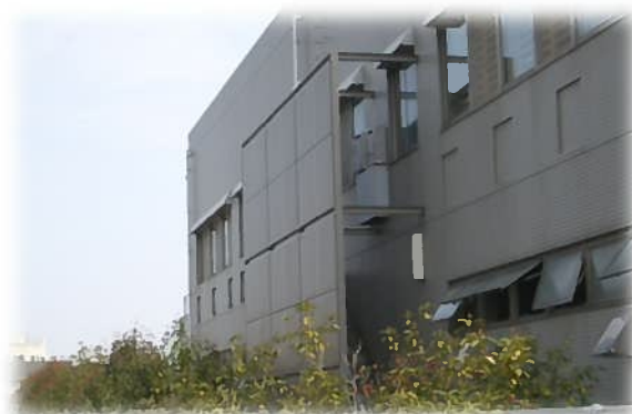
室外機の目隠し。建築物全体のデザインとの調和にも配慮されている。
