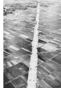
東海道新幹線工事着工 (平塚50年の歩み)
