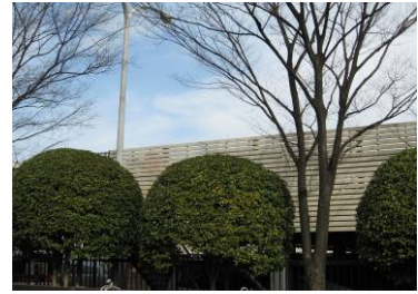
右写真：立体駐車場をルーバーで遮蔽し、周囲に植栽をしている事例
