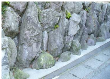
右写真：擁壁に石材を使い、自然の風合いを出している。
