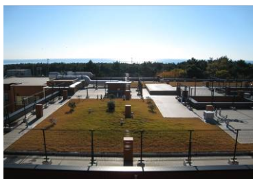
右写真：屋上に地被類による植栽をしている事例
